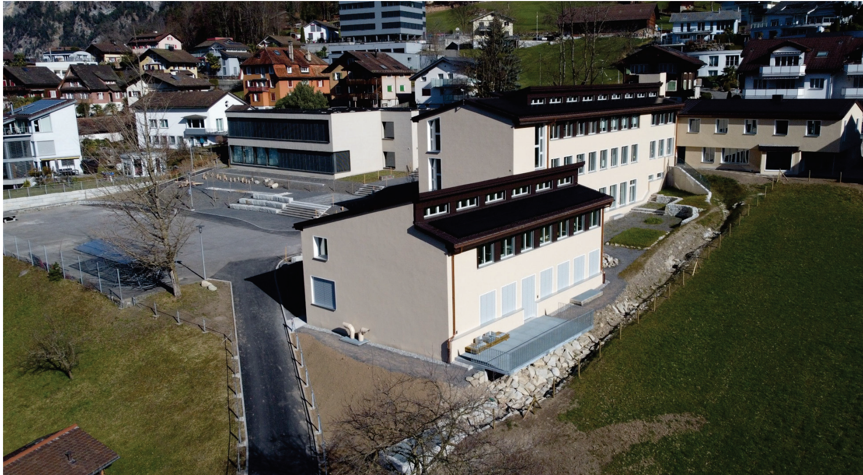
Gesamtsanierung Schulhaus Matte
